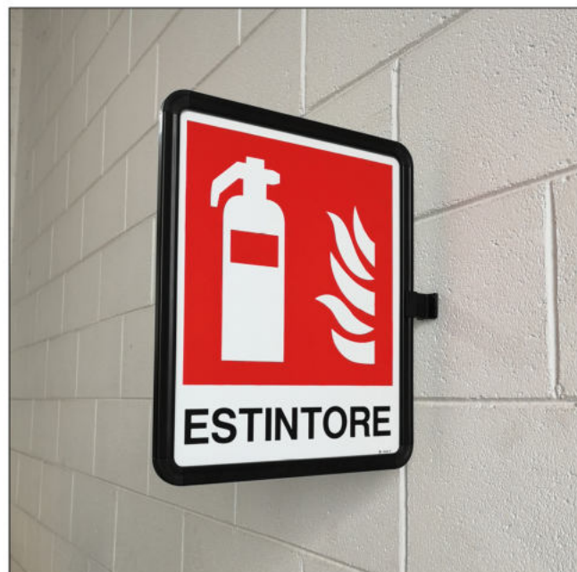
INSTALLAZIONE DI SEGNALI BIFACCIALI
